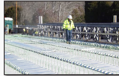
MD 234 bridge over Allens Fresh Run deck pour preparation
